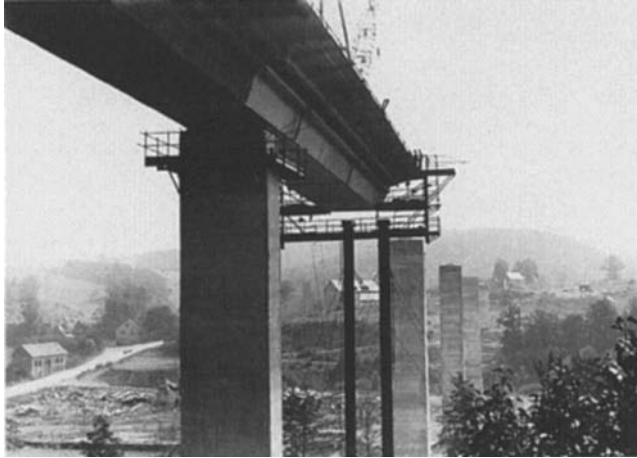
Fig. 17.3 A longitudinal view of the Zeulenroda Bridge during erection. (Ekdart: Die Stauseebrücke Zeulenroda. Ein Schadensfall und seine Lehren für die Idee der Ingenieurverantwortung. Stahlbau. With kind permission of Karl-Eugen Kurrer)
