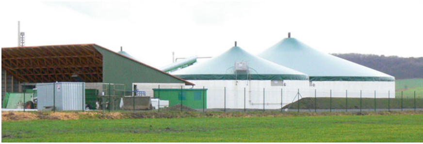
Fig. 2.17 Bio-gas power plant ( Source Regenerativ-Kraftwerk Harz GmbH and Co.KG)
